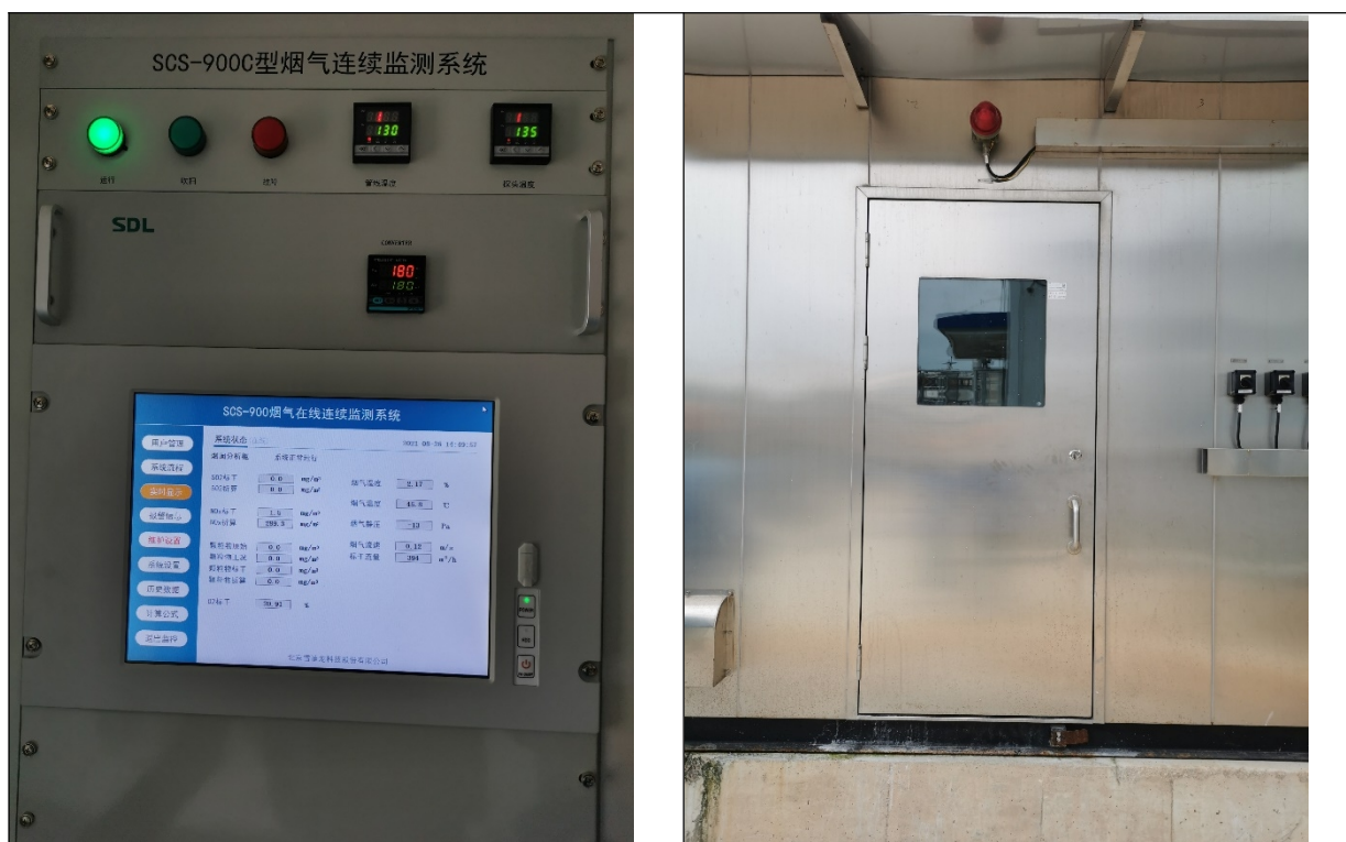
图 4.5-5 沼气锅炉在线监测现状
