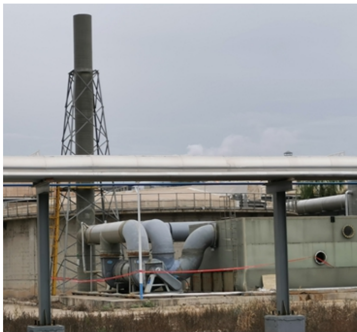
图 4.5-7 预处理系统废气处理设施
