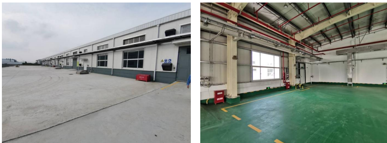
图 3.2.3 斯尔邦石化厂区现有危险废物仓库
