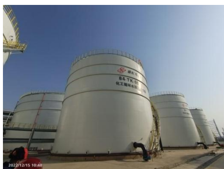
化工循环水排污调节罐
